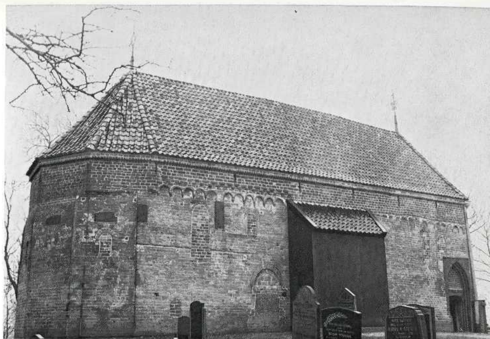
Noordgevel na de restauratie
