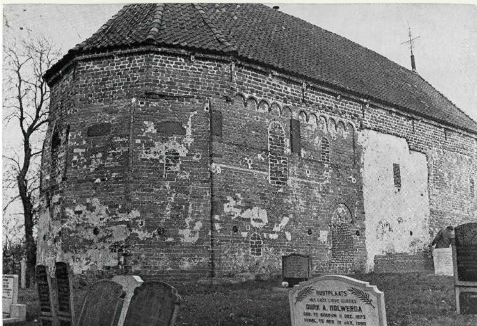
Noordgevel vóór de restauratie
