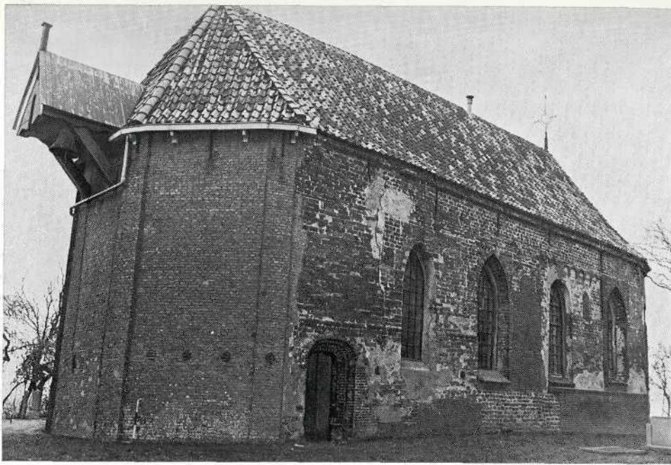
Zuidgevel vóór de restauratie
